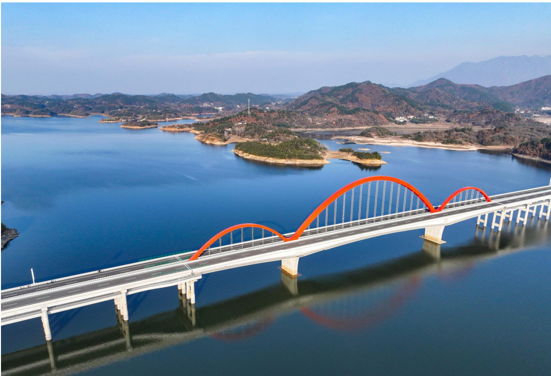
鲇鱼山特大桥
